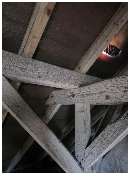
Figure 2: Intersection entre fermes, pannes et chevrons
